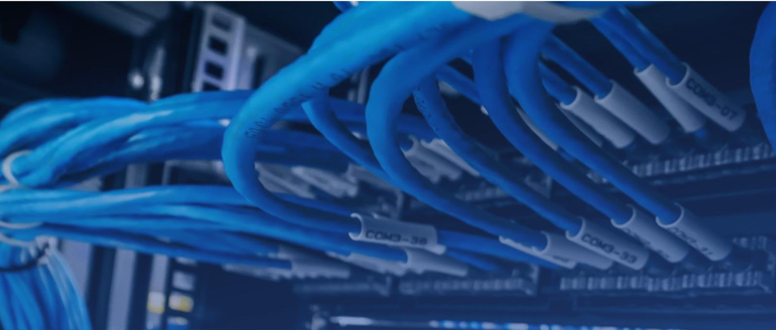
Alien Crosstalk ; La diaphonie exogène décrit l'influence électrique mutuelle indésirable entre les liaisons parallèles dans le chemins de câbles et à proximité des panneaux de brassage. Contrairement au NEXT et à l'atténuation, les perturbations dues à la diaphonie exogène ne peuvent pas être compensées électroniquement.
