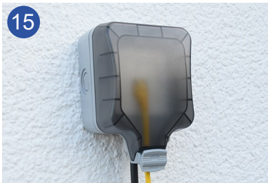
15 Verschließen Sie den Gehäusedeckel bis er fest einrastet - achten Sie darauf, dass das Anschlusskabel mittig in der Öffnung geführt wird.
