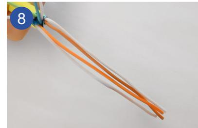
Entfernen Sie die Paarverdrehung der beiden Paare, formen Sie die Adernreihenfolge:
